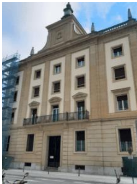
Obras de restauración de fachadas de la Subdelegación del Gobierno en Álava
