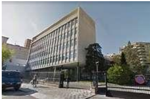
Fachada este del edificio sede de la Oficina de Extranjería en Lleida
